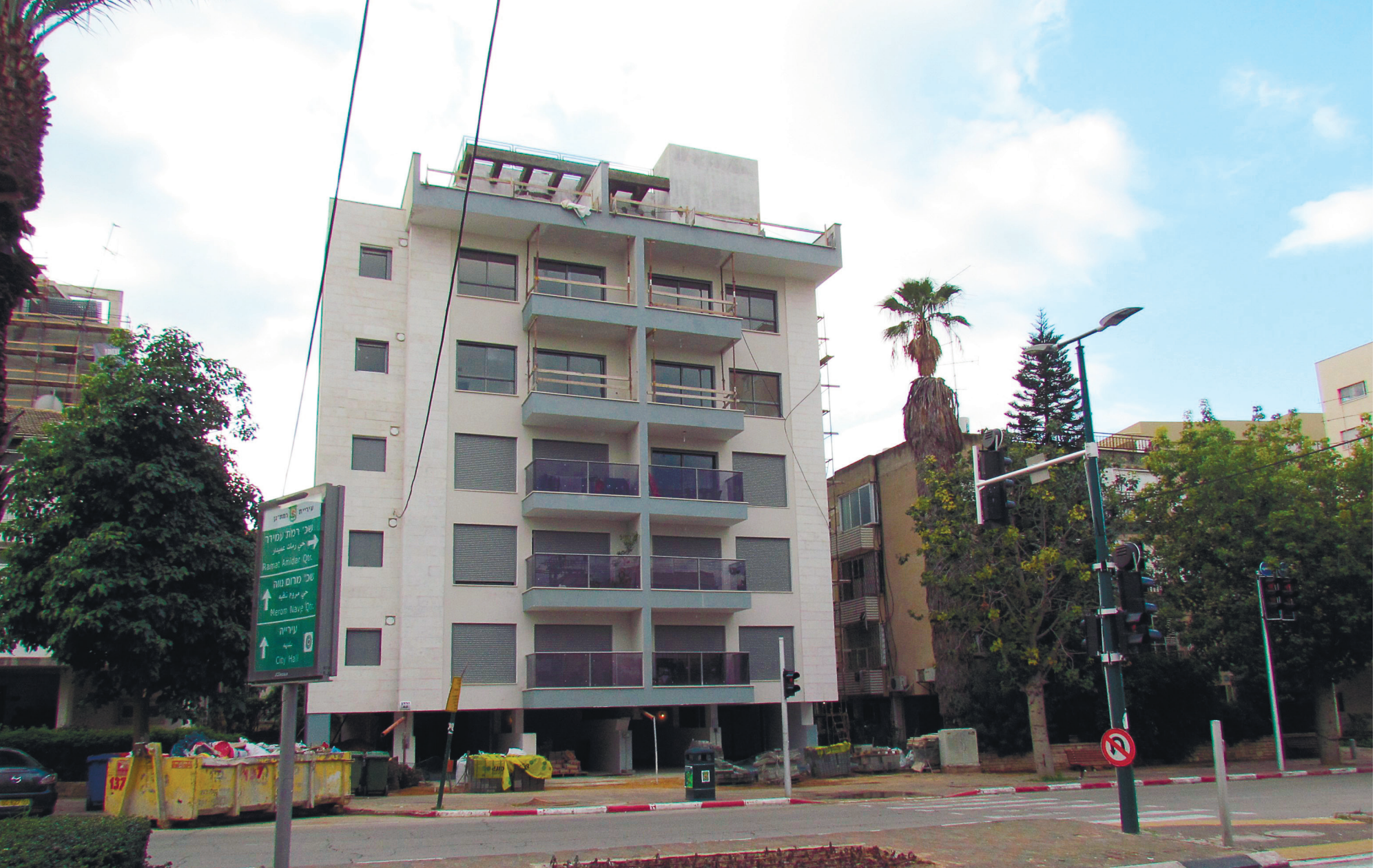
פרויקט תמ"א 38 הירדן 40, רמת גן. חברת כרכם מקבוצת א. וויס | צילום: כרכם
